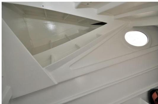
mois. La cabine avant est en cours de ponçage, et malgré quelques tâches noires où le poinçon s'enfonce un peu, les bordés sont sains. L'idée sera de peindre le tout en blanc, tout en laissant en bois apparent les lisses et les bords de passages avant, couchettes, etc. Le carré aussi est en court de ponçage, la cloison et l'épontille de mât sont saines, la coque et les bordés aussi. Le cockpit nous a donné quelques heures de travail supplémentaire non prévus
